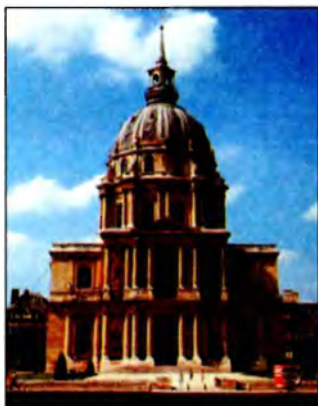
Церковь дома инвалидов. Архитектор Жюль Монсар. Париж, Франция
